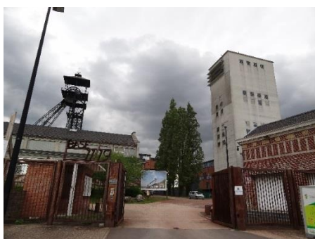
Vue sur le carreau de fosse du 11-19
