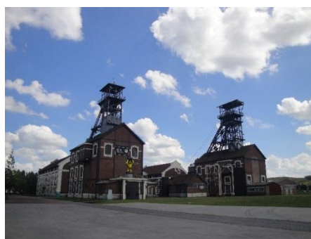
Vue sur le carreau de fosse du 9-9 bis
