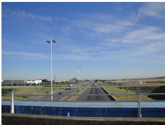
Vue au-dessus de l'A1 vers le terril St Henriette
