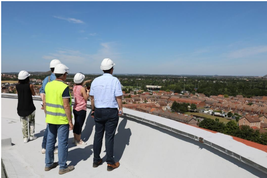
Vue du sommet du nouveau château d'eau communautaire en construction. Zone d'activité des Alouettes - Bully-les-Mines, Crédit photo : CALL, février 2020
