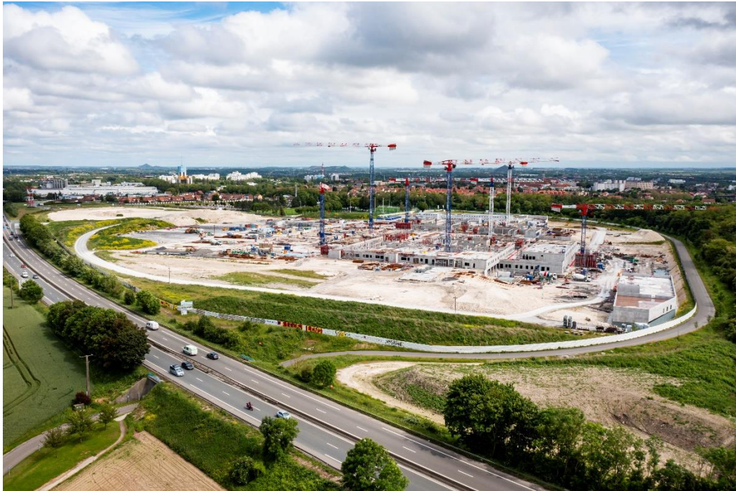
Centre Hospitalier Métropolitain de l'Artois en cours de construction à LENS/LOOS-EN-GOHELLE - Crédit photo : SCoT LLHC, 2024
