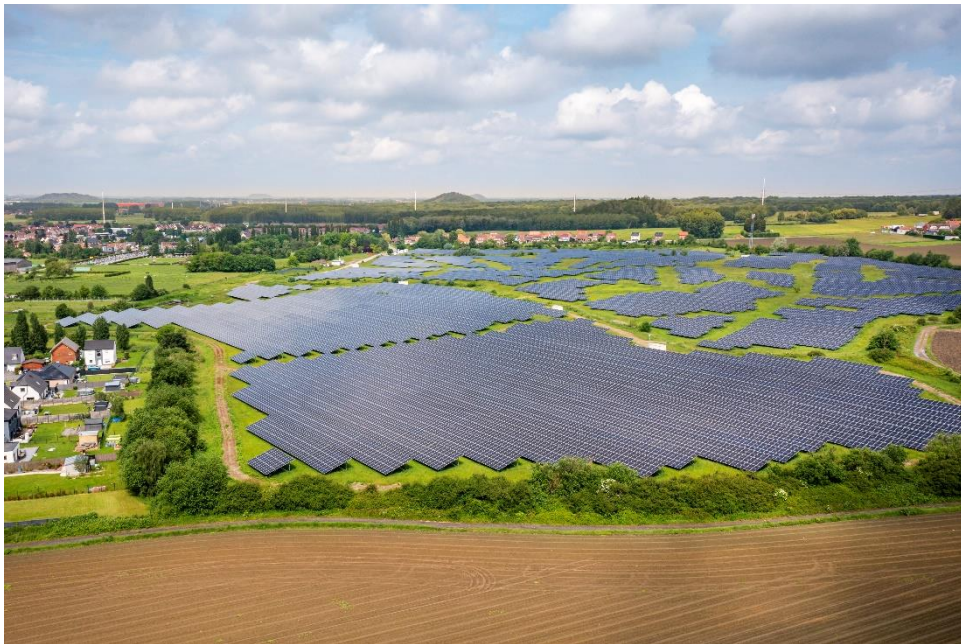
Centrale solaire de panneaux photovoltaïques à LEFOREST – Crédit photo : SCoT LLHC, 2024
